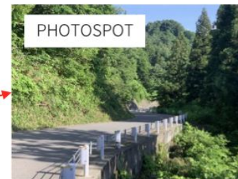
緩いカーブが連続する場所
